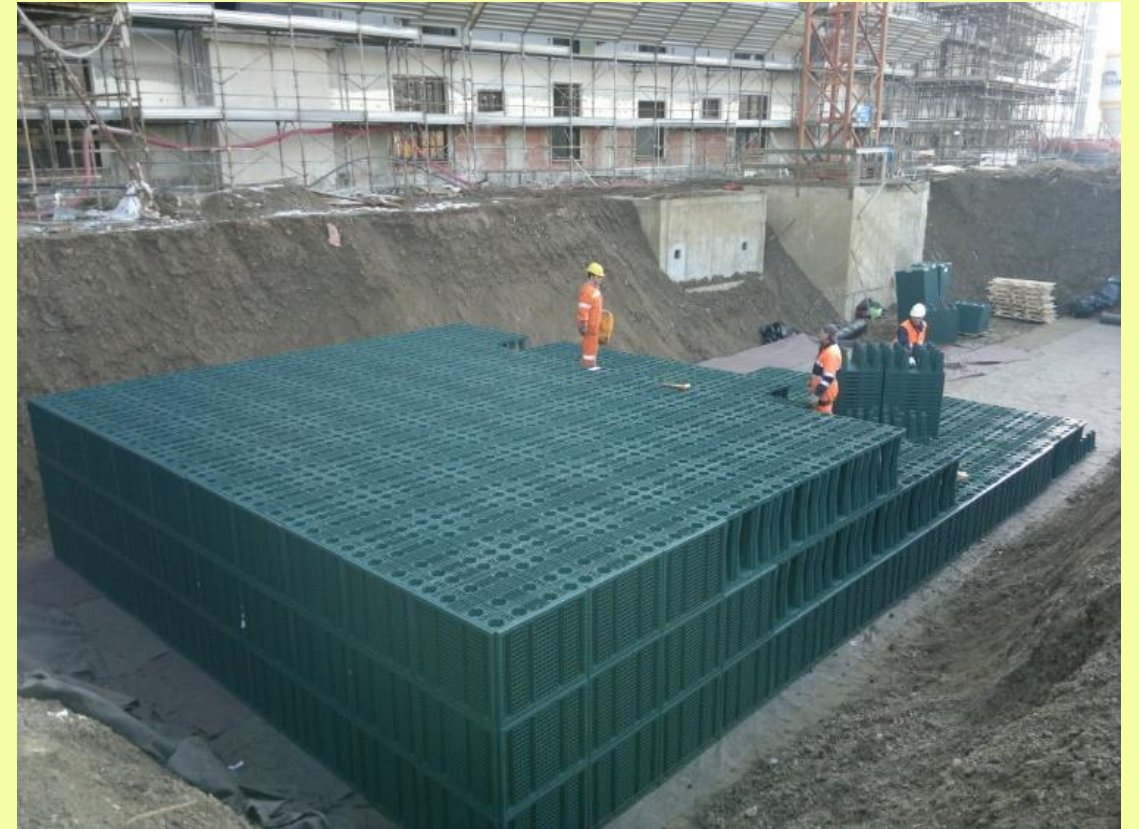
trincee drenanti a moduli prefabbricati
